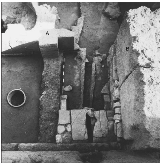
Figura 15. Solar de la ampliación del Ayuntamiento en la Plaza de Belluga de Murcia. Obsérvese la atarjea que recogía las aguas pluviales en el patio de la casa 2 y se hacía coincidir con la canalización de la letrina antes de desaguar en el alcantarillado de la calle.
