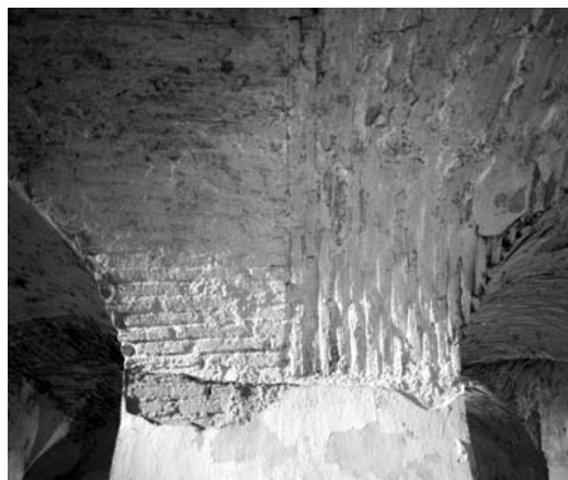
Figura 2 Encuentro entre bóvedas de arista roscadas radialmente y «a bofetón» en el nivel 2 de la torre del Homenaje de la Alhambra
