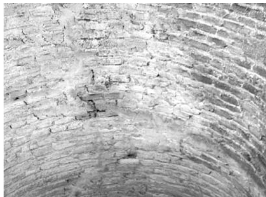
Figura 1 Bóveda con ladrillos sentados «a bofetón» de la Torre de la Vela de la Alhambra
