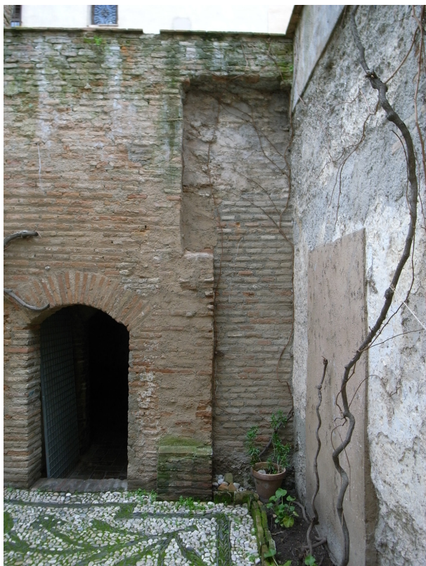
4.—Detalle de la zona en que pudo engarzarse el pórtico septentrional de la sala de reposo.
