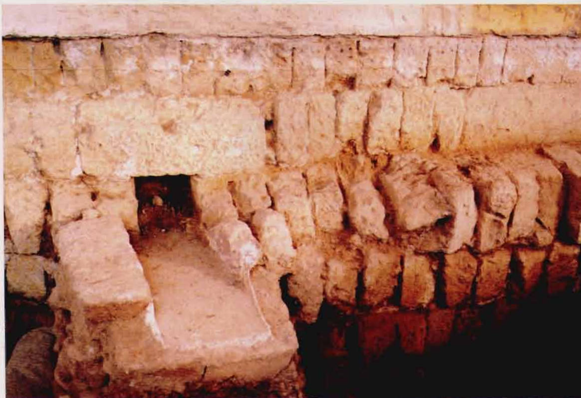
Cimentación del muro norte del Patio de los Naranjos en la zona ampliada por Almanzor. A la izquierda, una atarjea de la misma época. (Fotografía P. Marfil).
