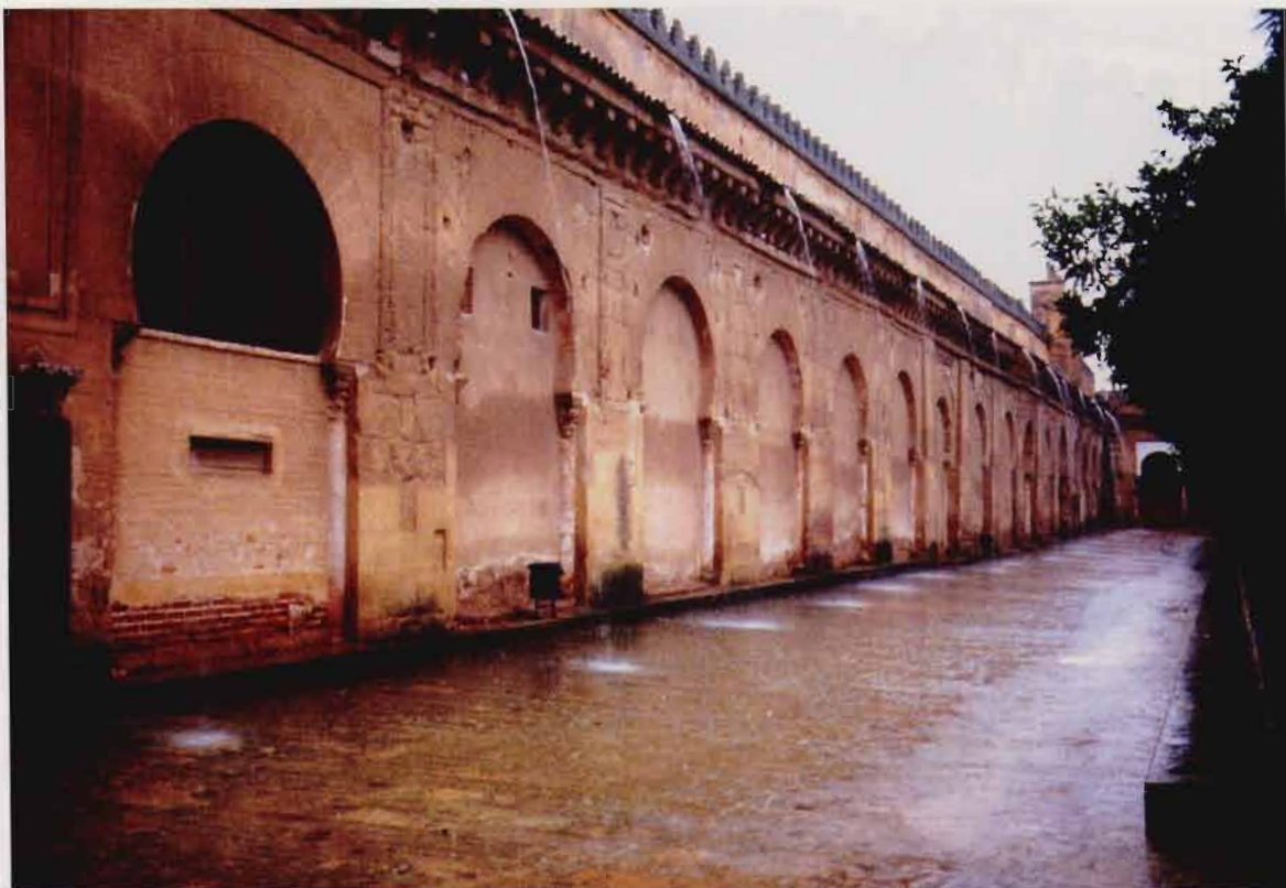
Fachada del oratorio al patio. Zona edificada por Almanzor. (Fotografía P. Marfil).
