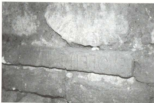
Fig. 7.—Estructuras de opus vittatum mixtum con inscripción paleocristiana bajo la sala de oración de Abd al-Rahmán I en la Mezquita.
