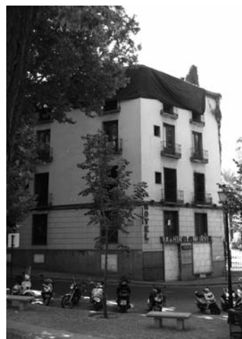
Fot.5 Estado actual del Hotel Washington Irving.
