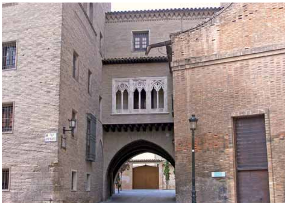
Fig. 10. Calle encubierta próxima a la Seo de Zaragoza.
