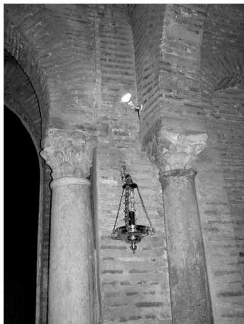
Figura VI. Capiteles reutilizados en la capilla de los Hinestrosa (s. XIII) de la iglesia de Santa Marina
