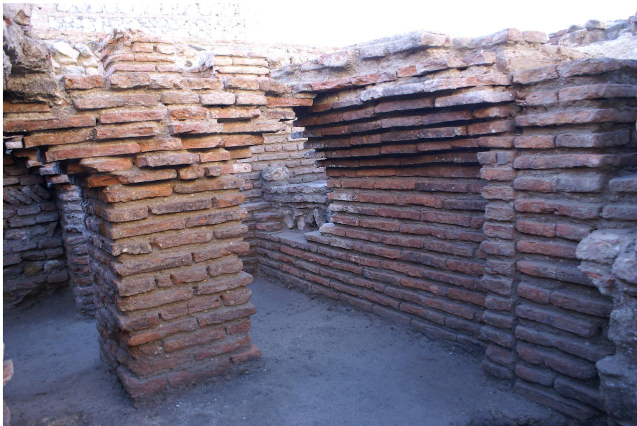
Fig. 12. Baño. Interior del hipocausto que hay bajo el pavimento de la parte central de la sala caliente.
